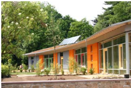
Neubau Kita Döbeln
